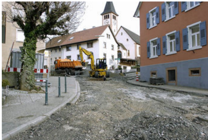
Hochwasserchäden werden in der Oberdorfstraße in Dörlinbach beseitigt. | Foto: heidi fössel
